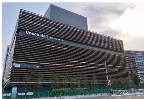
区民文化センター 外観
